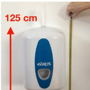
1. La altura recomendable para la instalación del dispensador es **aproximadamente 125 cm** (distancia entre el suelo y la parte superior del dispensador).
